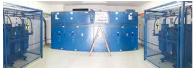
Umbauarbeiten am Eigenbedarf
