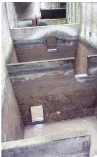
Reinigung der trockengelegten Fischpassbecken
