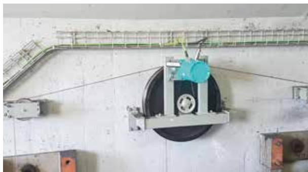
Neue Positionsgeber beim Wehr
