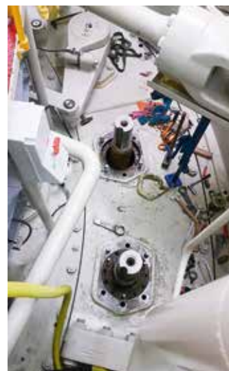
Dichtungersatz bei den Leitschaufellagern
