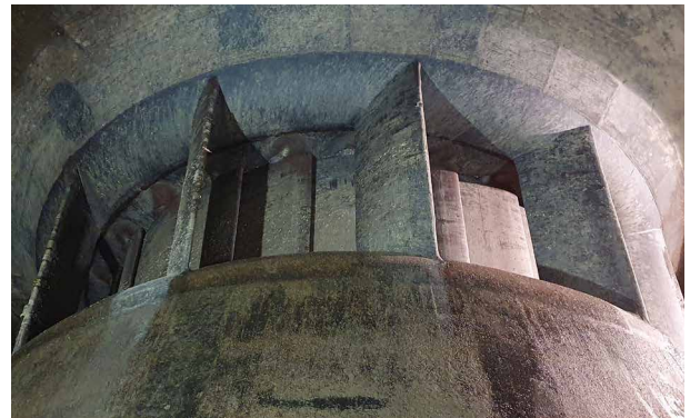
Stützschaufelring mit geschlossenem Leitapparat
