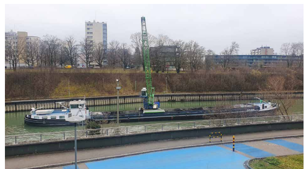
Beseitigung von Auflandungen im Schleusenvorhafen
