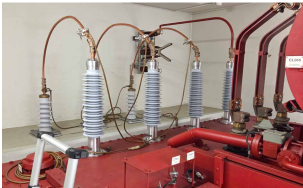
Ersatz der Trafo-Durchführungen
