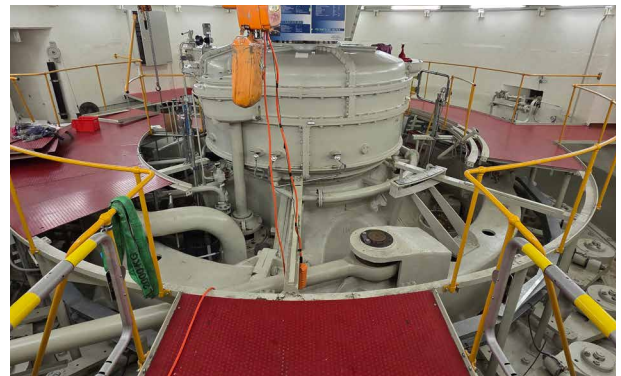
Revision diverser Pumpen und Ventile
