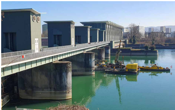
Erdbebenverstärkungen im Unterwasser des Wehrfelds 3
