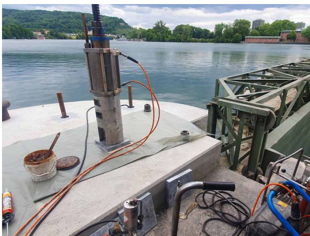
Vorspannung eines Mikropfahls auf dem Wehrpfeiler 4
