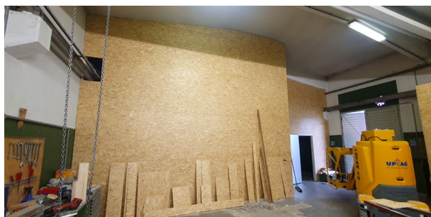
Neue Malerwerkstatt im Pumpenhaus
