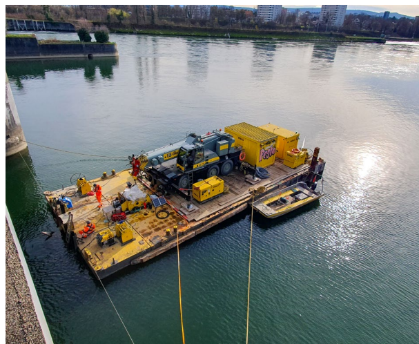
Kernbohrarbeiten unterhalb des Wehrs
