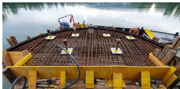
Betonierarbeiten auf den Wehrpfeilern
