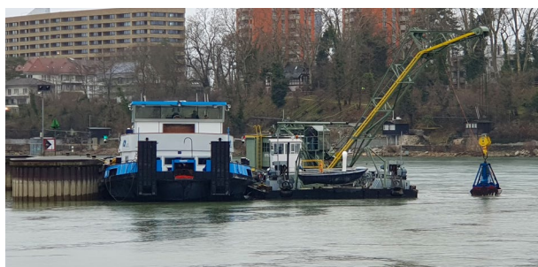
Beseitigung von Auflandungen mit unserem Schwimmbagger
