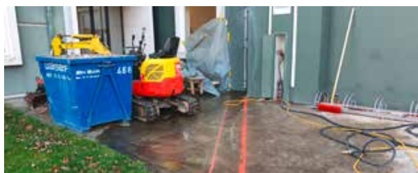
Reparatur Abfluss Dachwasser
