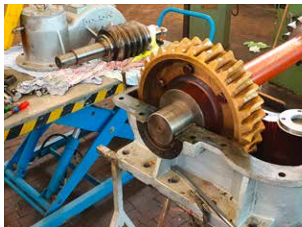
Reparatur Lagerschaden Wehr 5
