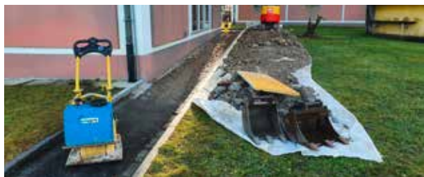
Neue Anschlüsse für Entwässerung
