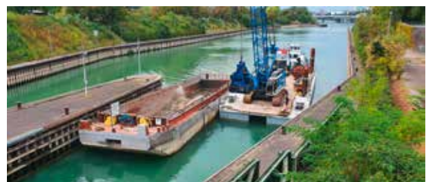
Baggerung im unteren Schleusenvorhafen
