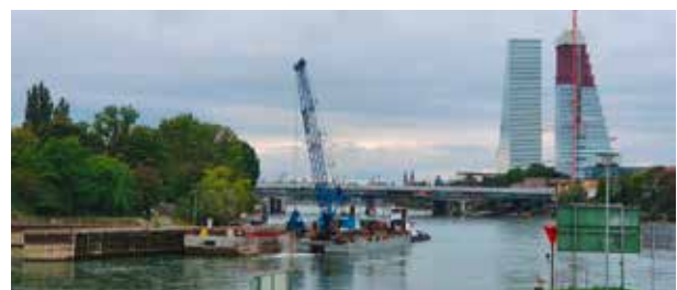
Baggerung bei der Hakenbühne
