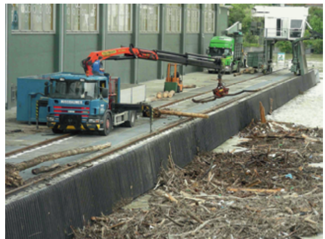
Angeschwemmtes Holz am Einlaufrechen.....
