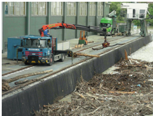
Angeschwemmtes Holz am Einlaufrechen.....
